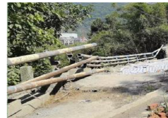
既有道路防护设施
