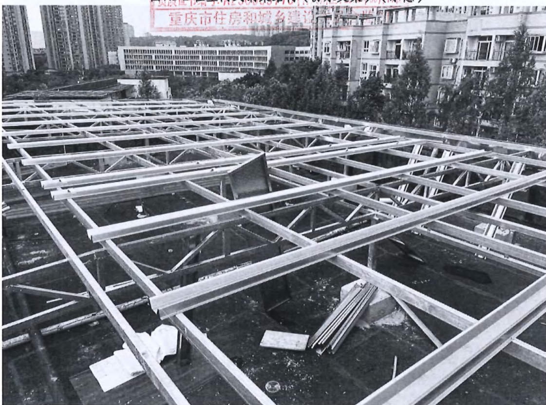
图7.3-3 轻型门式钢架结构（防水支架）（示意）
