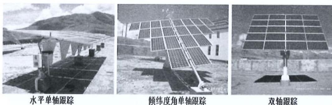
图5.3-2 跟踪安装方式布置图
