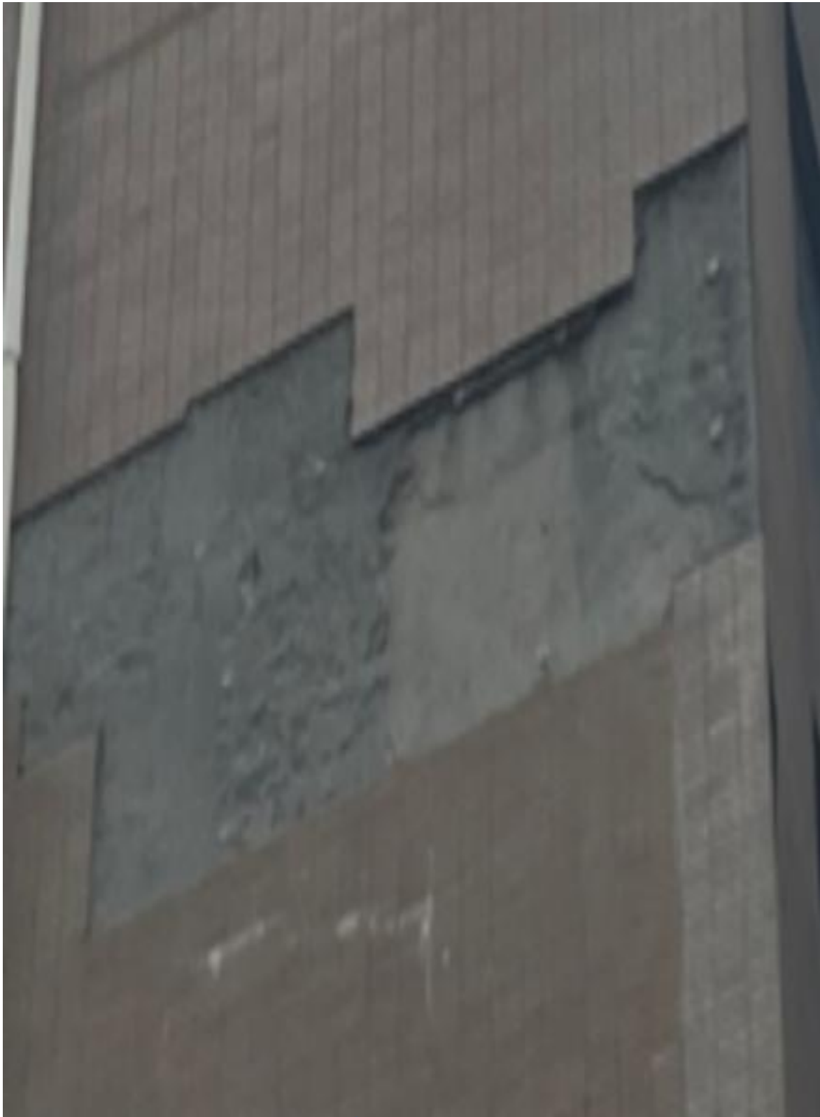
原有外墙面瓷砖脱落渗水，基础处理找平涂抹界面剂
