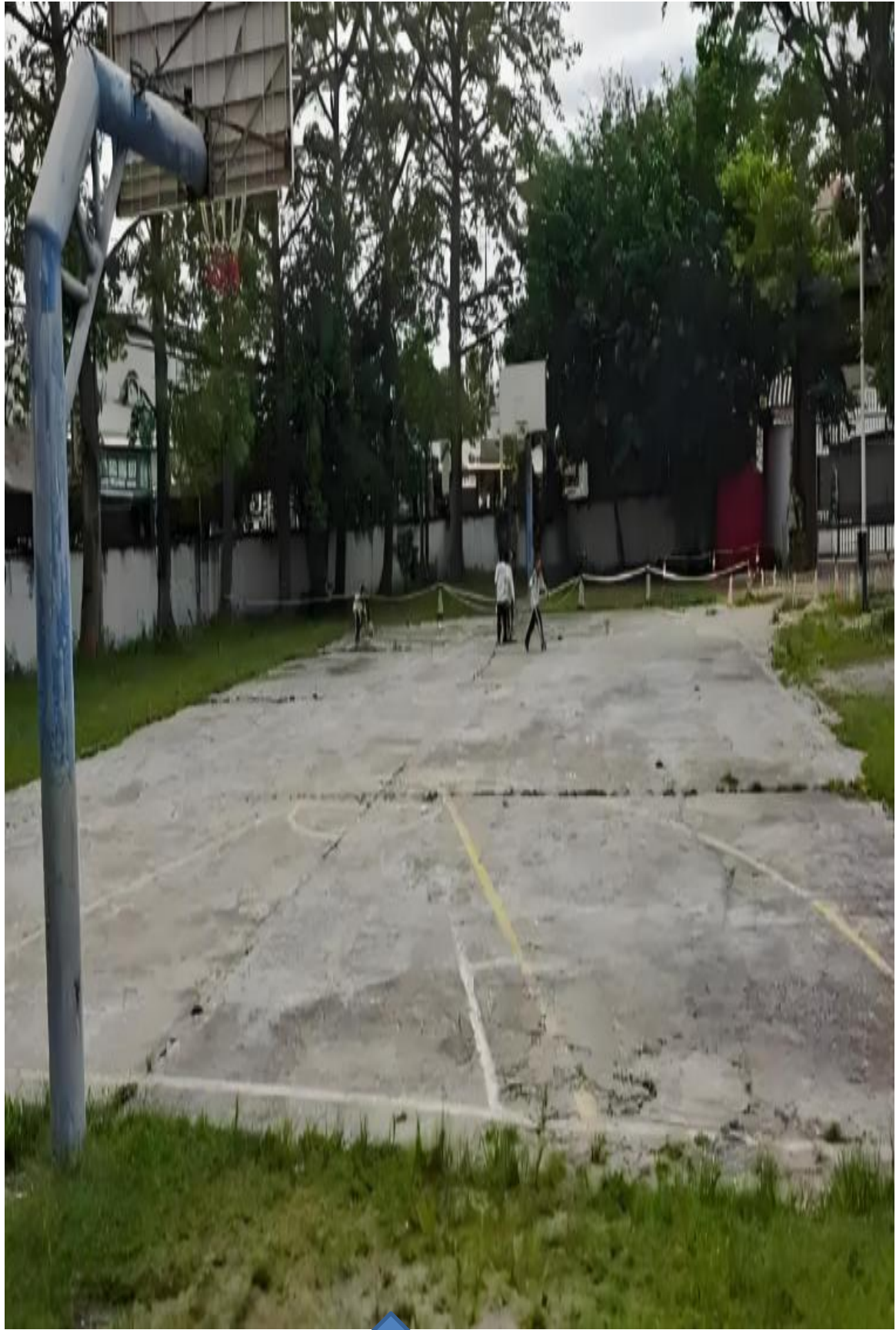
原有篮球场青石板及基础拆除
