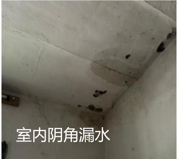
室内墙面漏水
