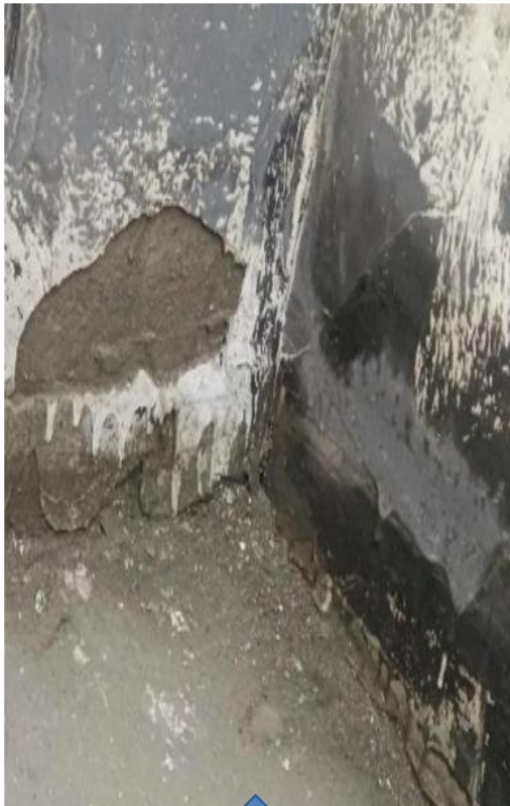
原有水泥砂浆保护层及SBS防水拆除
